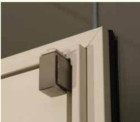
Türband in Edelstahl. Massivtür.
