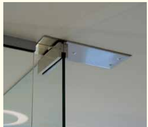
Ganzglastür mit Zapfenbändern und Türschließer.
