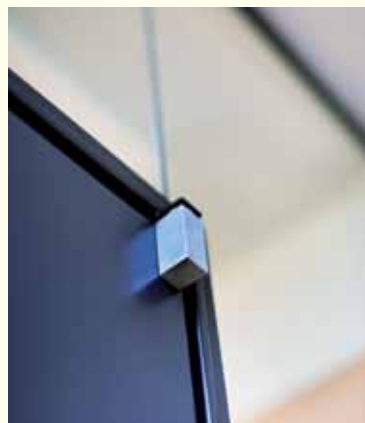
Zapfenband in T-Profilzarge.
